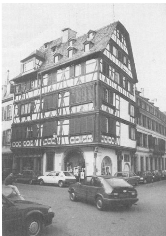
9. Place St-Étienne. Maisons à colombages.
